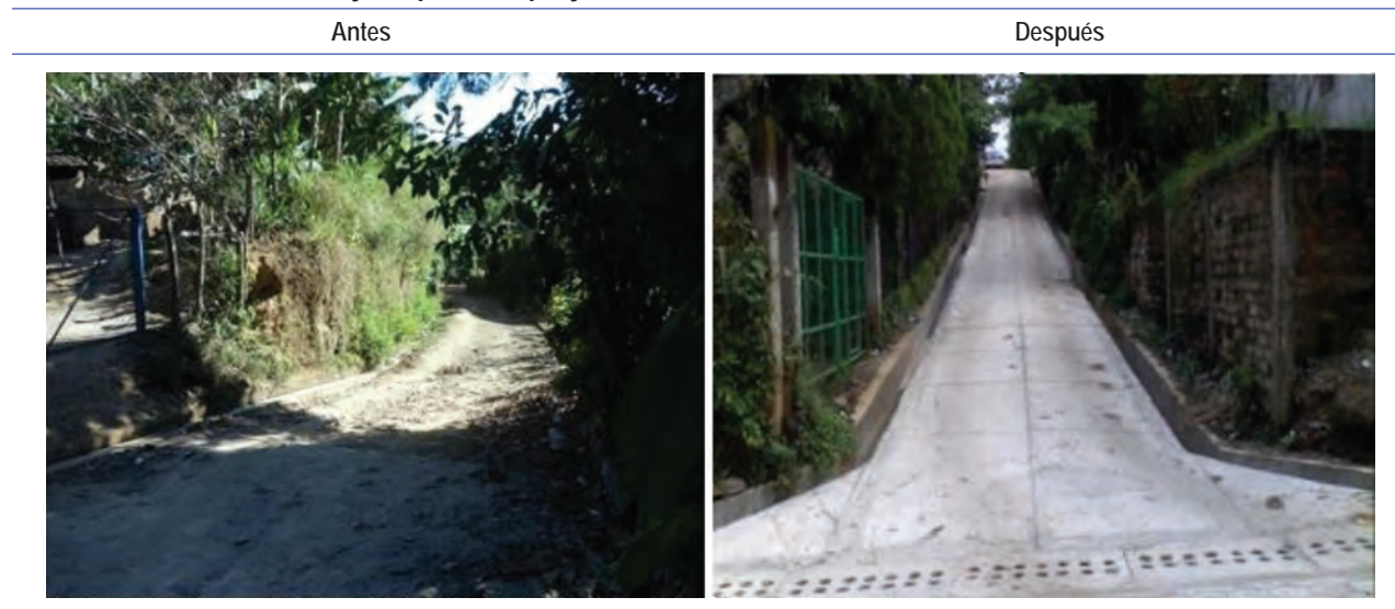
FIGURA A2.6. Estado antes y después del proyecto MIAUP El Chilar, Ciudad Arce
