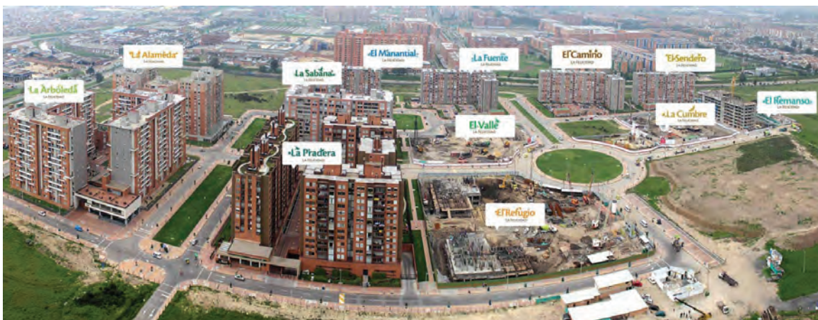
FIGURA 4.3. Avances de obra, abril de 2013
