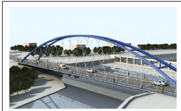
El tablero de hormigón pretensado equilibra la componente horizontal del empuje de los arcos, de manera que la superestructura transfiere principalmente fuerzas verticales a la infraestructura.
