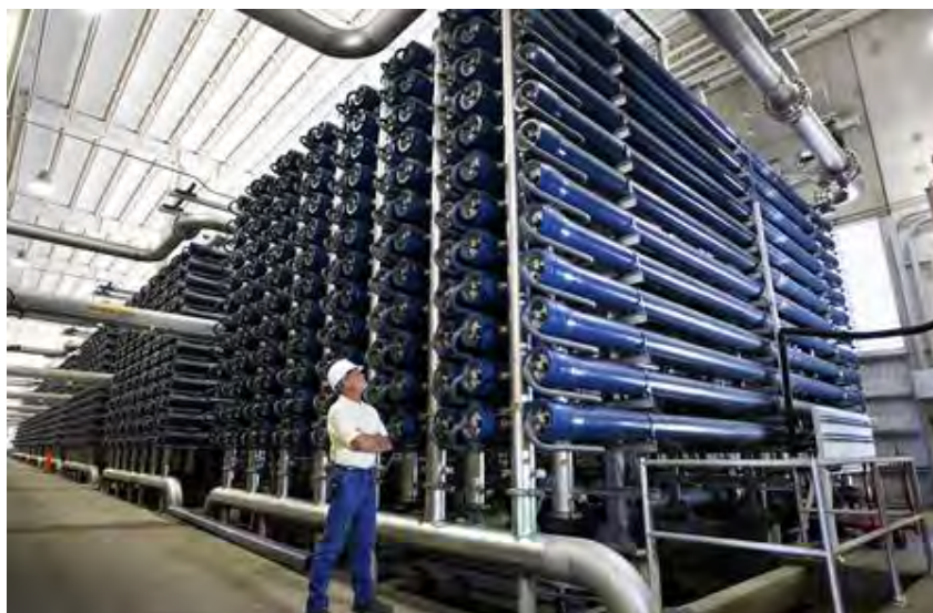
Planta desalinizadora de agua de mar por Osmosis Inversa
