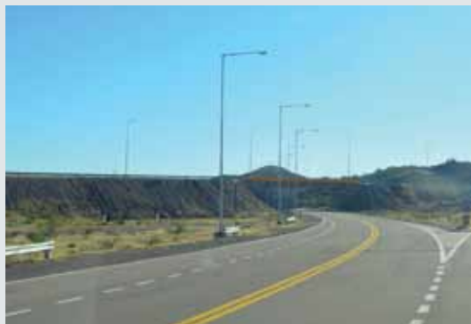
Empalme RN 40 y RN 150.
