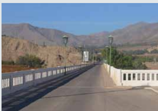
Puente de ingreso a Vicuña. Vista hacia la ruta 41-CH.
