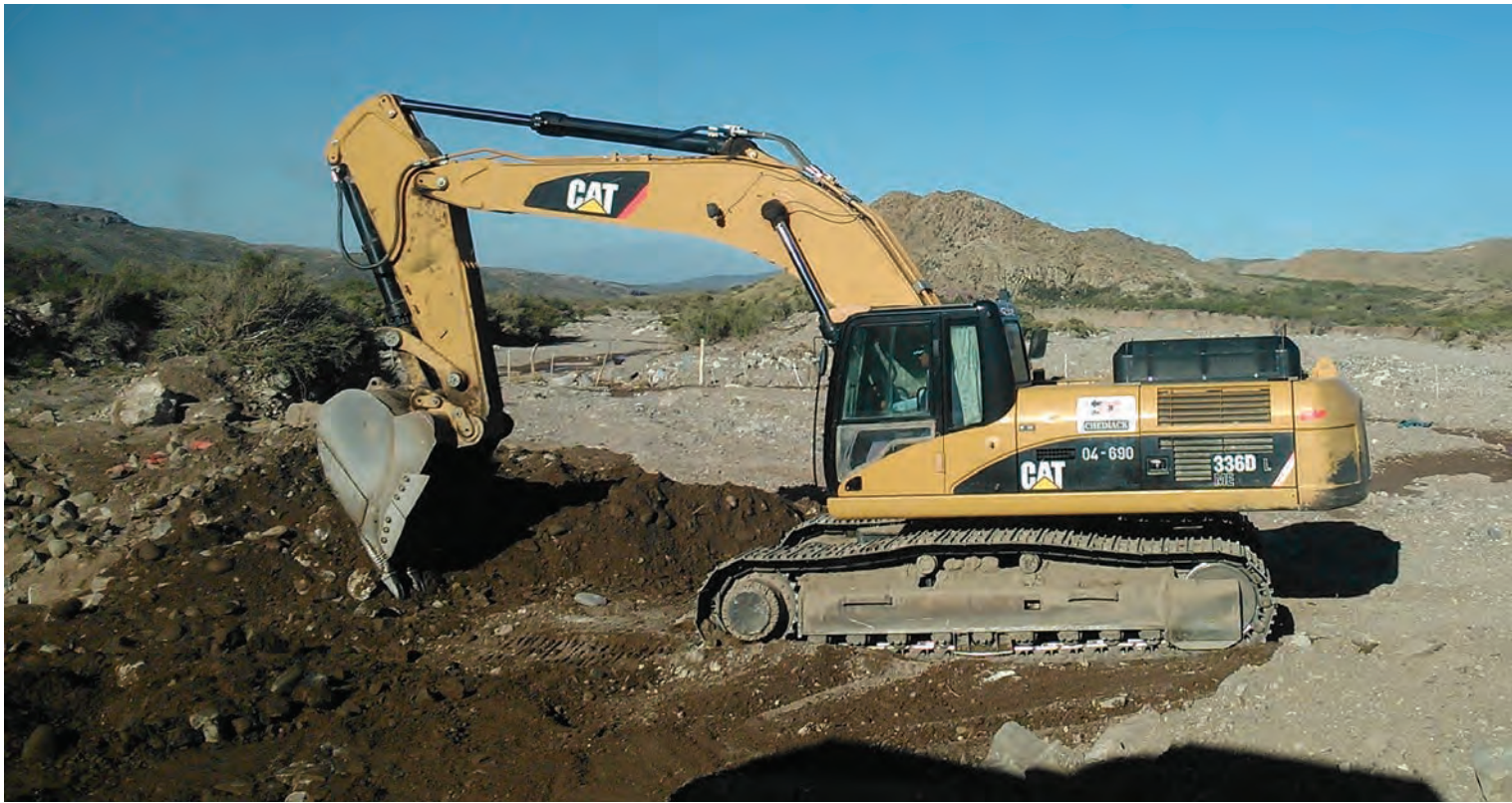
Foto. Grúa en zona de obras, Departamento de Malargüe, Provincia de Mendoza.
