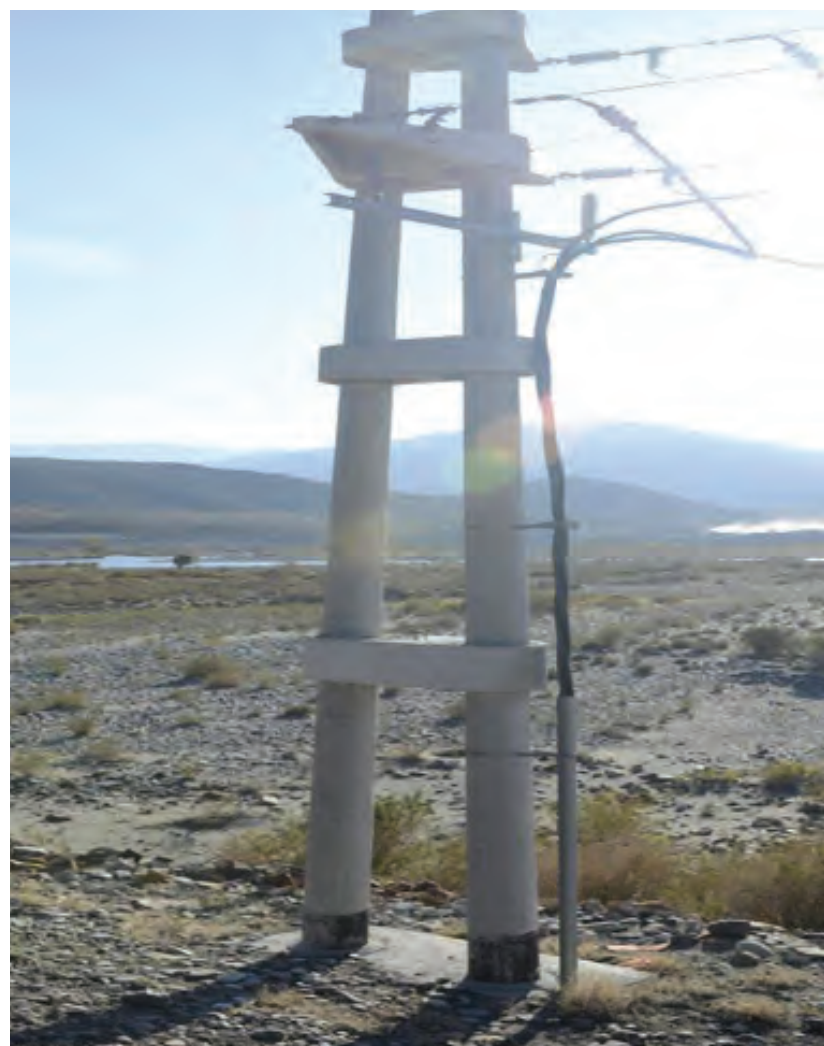
Foto. Poste eléctrico, Bardas Blancas.
