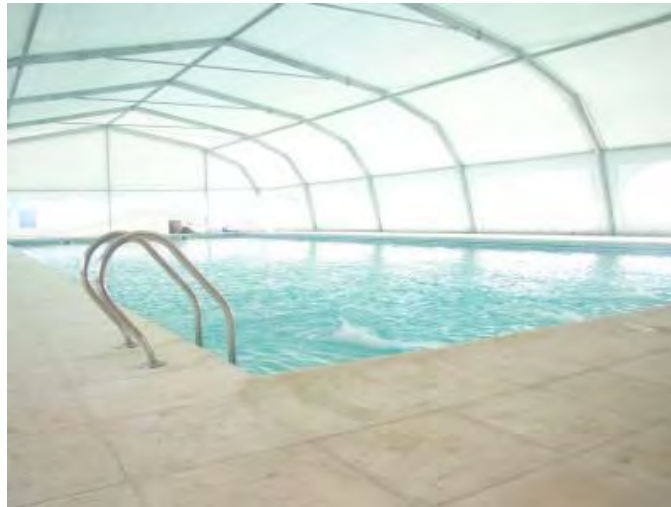
CRIM – Imagen del interior de la piscina cubierta
