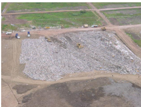
CEAMSE: a. Cava con relleno
