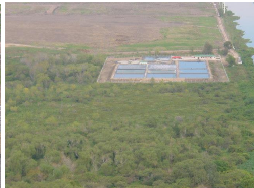
b. Planta de tratamiento de lixiviados
