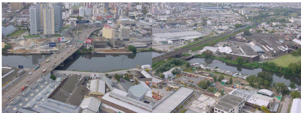
Nuevo Puente Pueyrredón (vista desde la Ciudad de Buenos Aires)
