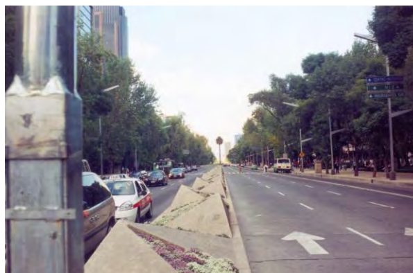
37-PASEO DE LA REFORMA, MÉXICO DF. SEP. 2005
