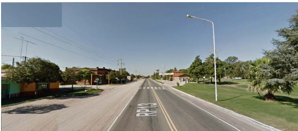
Imagen actual de la Ruta Provincial N°13 . Sector Parador de Ómnibus Interprovincial.
