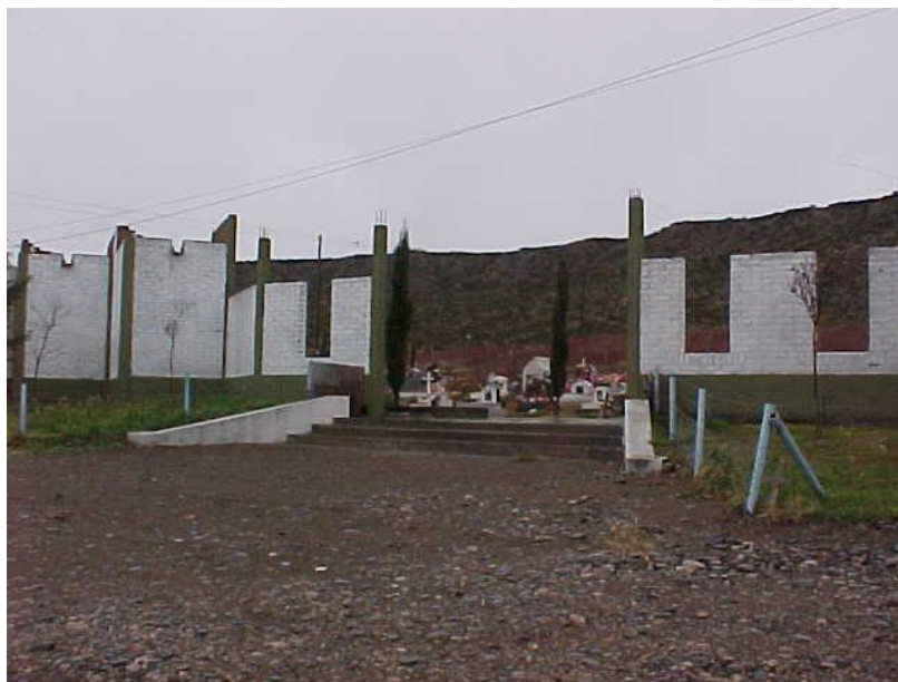
Acceso al cementerio por Colectora Norte-
