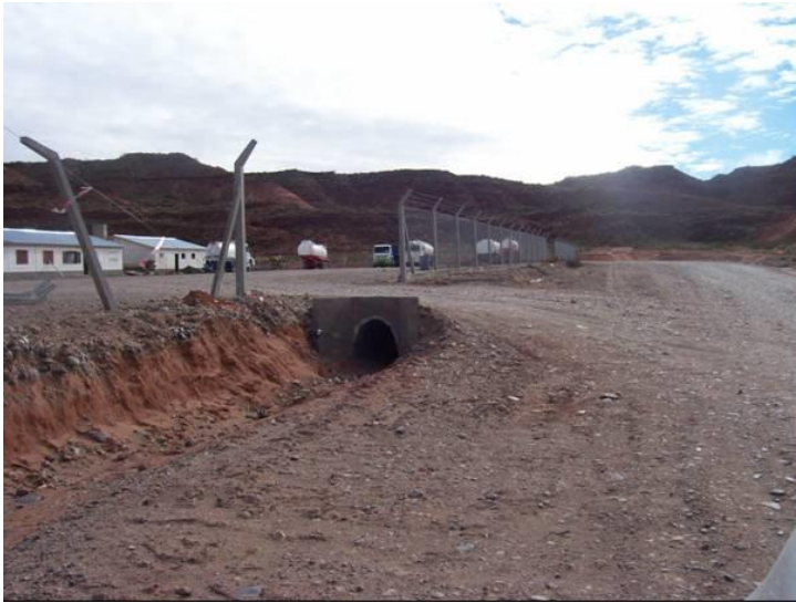
Situación de escurrimiento pluvial actual
