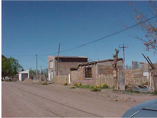
Diferencia en el nivel de consolidación de la vía pública
