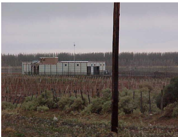
Bodega de Añelo
