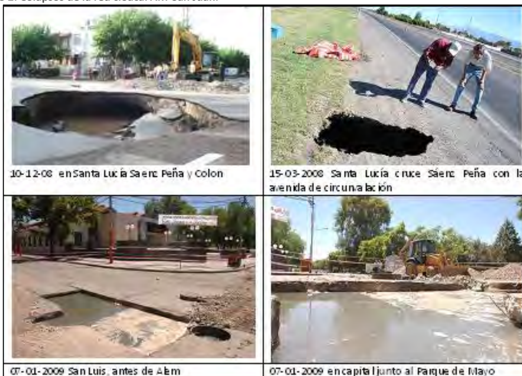
Foto 2: Colapsos de la red cloacal AM-San Juan.
