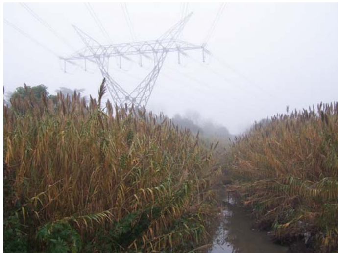
5.2 Torre de alta Tensión en la Reserva de Hudson
