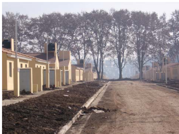
8.2 Plan Federal de Construcción de Viviendas. San Miguel
