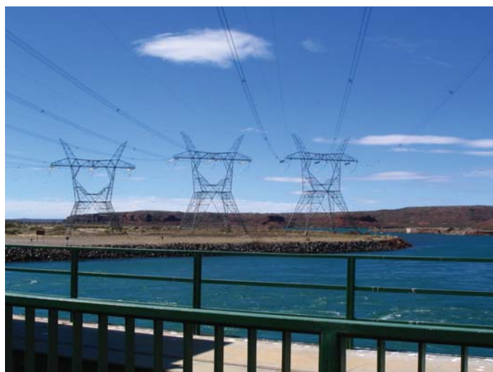
5.2a Las tres primeras torres de alta tensión del sistema. El Chocón
