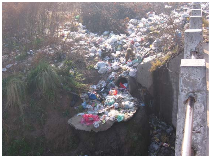
5.6a Detalle de depósito de basura. Arroyo Las Catonas.
