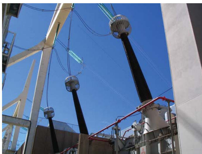
5.2b Detalle de transformadores de alta tensión. El Chocón
