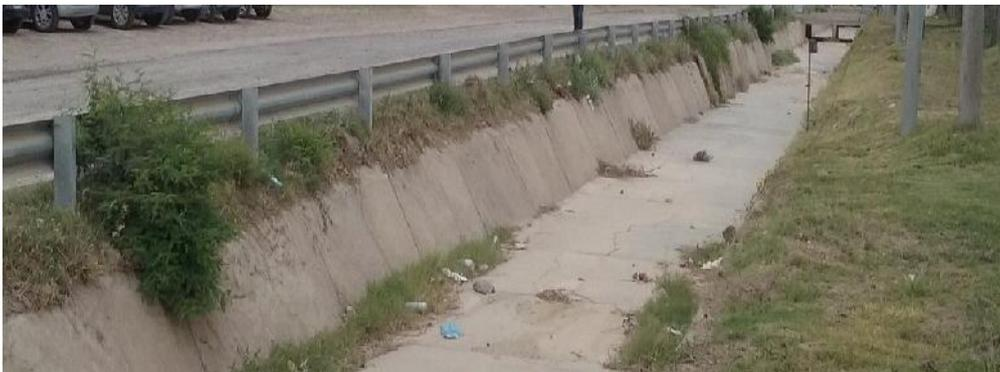
**Ilustración 5: Sección Tipo del Canal N° 2 en el que se Observan Fisuras en las Losas y Gramilla creciendo entre las Juntas / Fisuras a Reparar**
