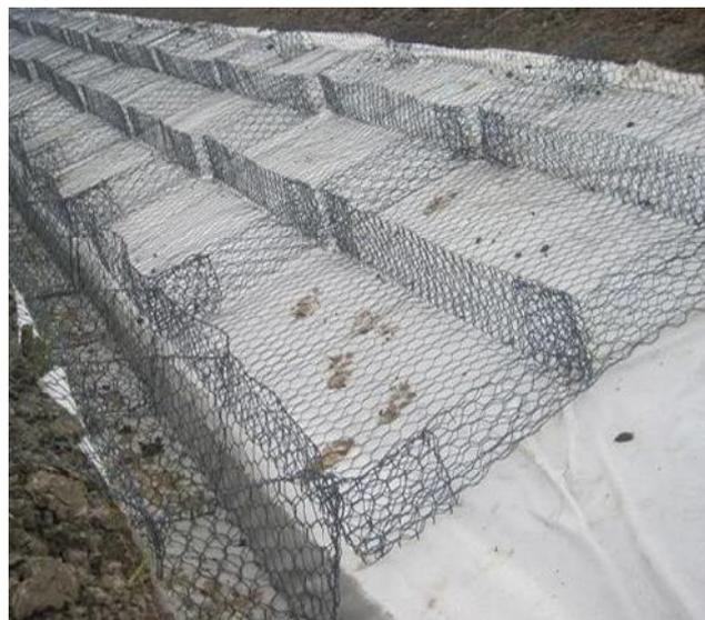
**Ilustración 35: Estructura de Colchonetas y Gaviones Típico de Obra de Protección del Camino Costanero**
