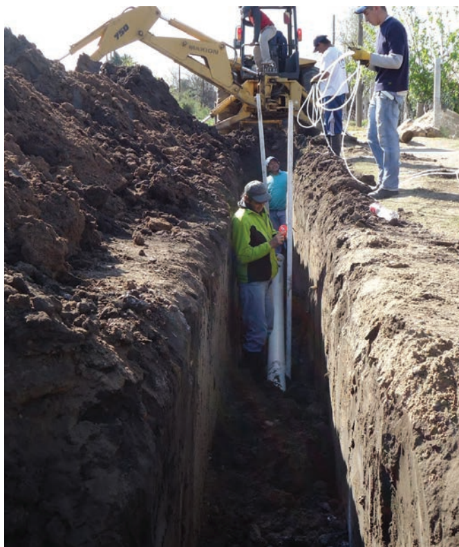
Foto. Obras públicas, Barrio de Florida, Provincia de Buenos Aires.
